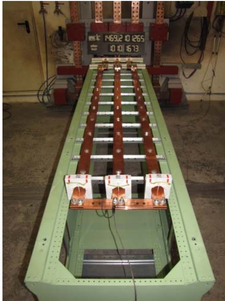
Foto 1: 60 mm x 10 mm-Sammelschienensystem, Stützabstand 200 mm nach der Stoßstromprüfung
