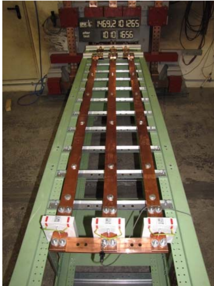
Foto 2: 60 mm x 10 mm-Sammelschienensystem, Stützabstand 400 mm nach der Stoßstromprüfung
