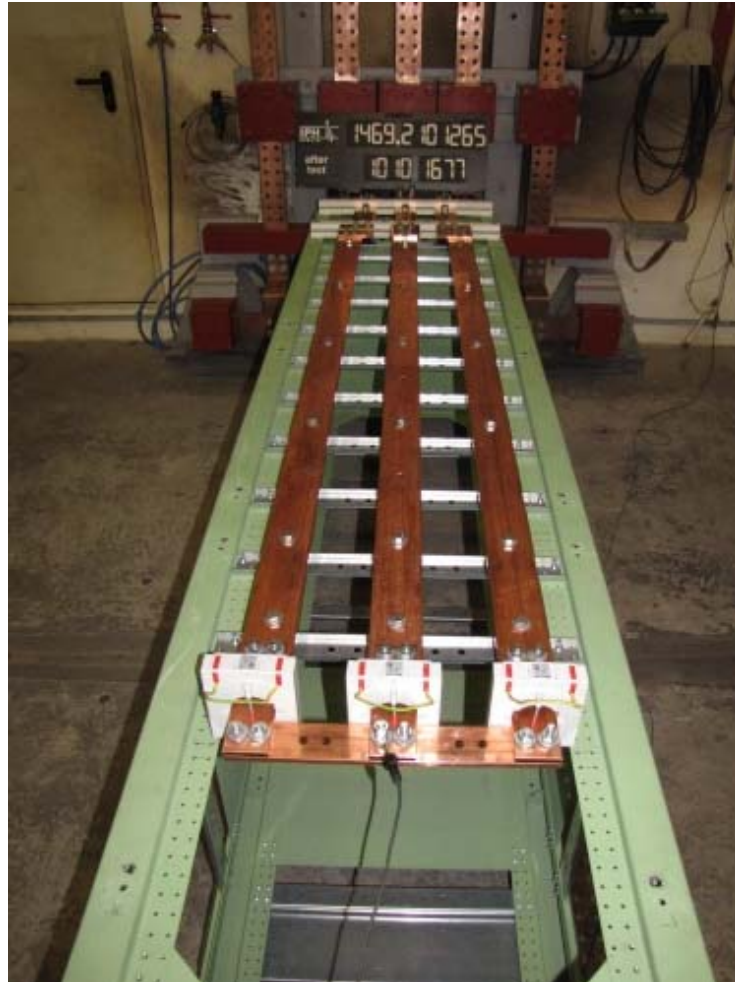
Foto 6: 80 mm x 10 mm-Sammelschienensystem, Stützabstand 600 mm nach der Stoßstromprüfung
