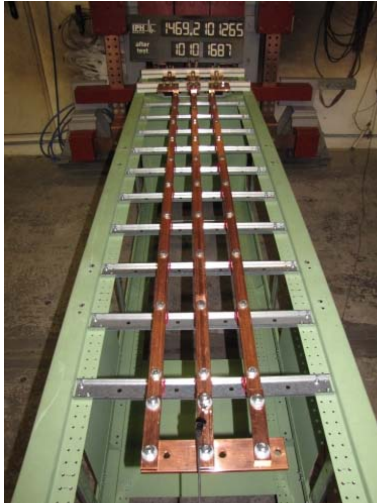
Foto 7: 30 mm x 10 mm-Sammelschienensystem, Stützabstand 200 mm nach der Stoßstromprüfung
